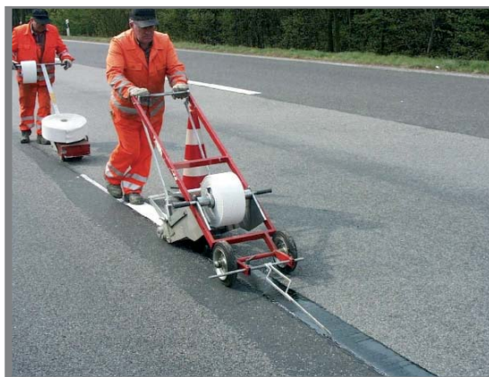
Figuur 5.17 Aanbrengen en aandrukken van tape in een gefreesde sleuf
