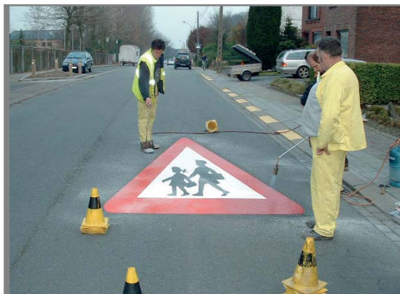
Figuur 5.9 Aanbrengen van een voorgevormde thermoplast
